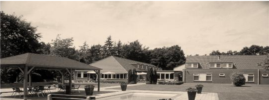
Hotel de Postelhof, Luyksgestel
